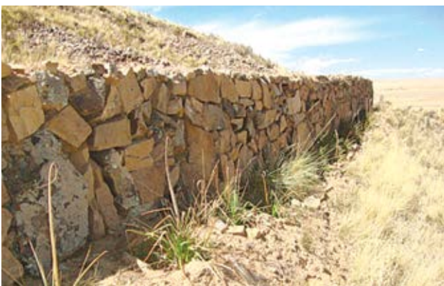
Foto 2. Takanas con talud de piedra y barreras vivas (sewenkas).
