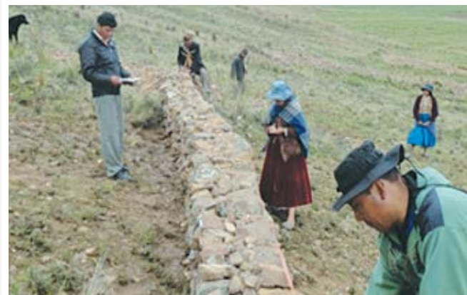
Foto 7. Evaluando la construcción de takanas
